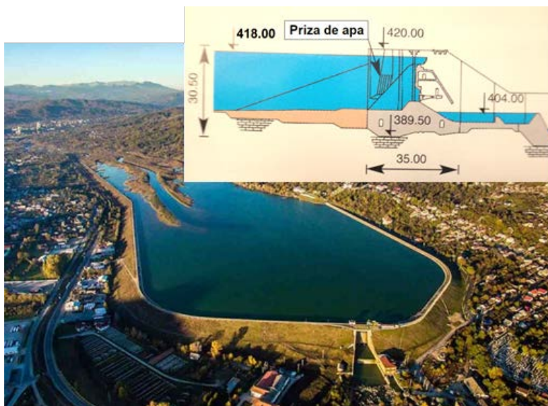
Fig. 12. Barajul și lacul de acumulare Pucioasa
