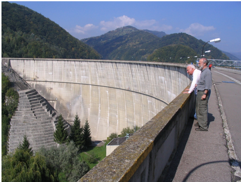
Fig. 8. Vedere a barajului dinspre sud-est
